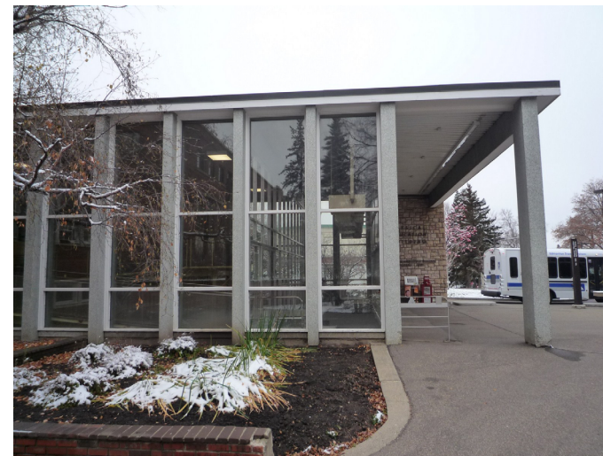
Existing Van Vliet Centre Entrance
